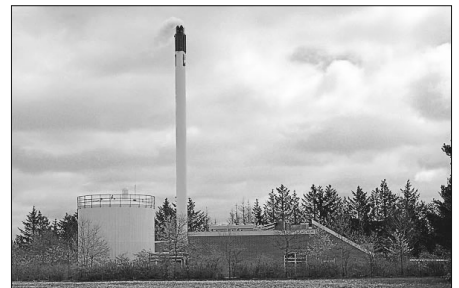
Når solvarmeanlægget er i drift, vil der blive udløst betydeligt mindre CO 2 til atmosfæren, hvilket glæder byrådet, idet Brønderslev i 2008 blev klimakommune.
